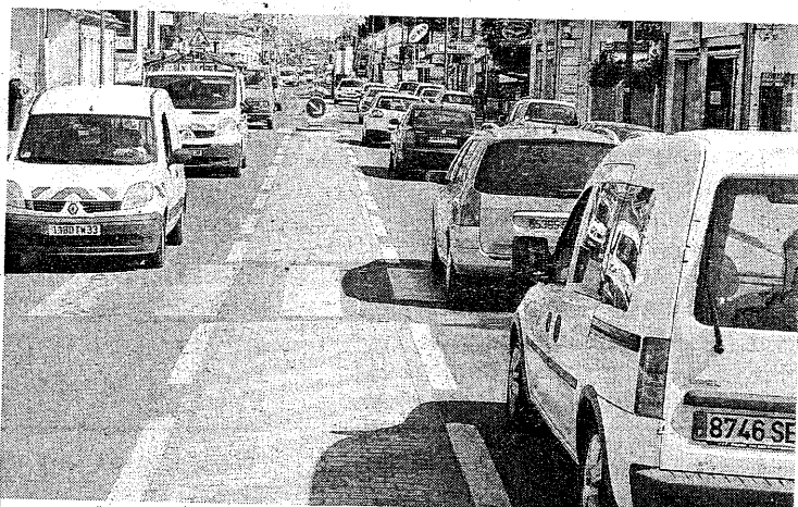
La route de Toulouse, large de 15 m, draine 27 000 véhicules par jour. Or, pour concilier tram et circulation, 25 m de largeur sont exigés. PHOTO D. A.
