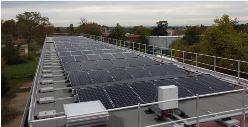
Installation des panneaux photovoltaïques sur les toits d'une école au Burck. (©Ville de Mérignac)
