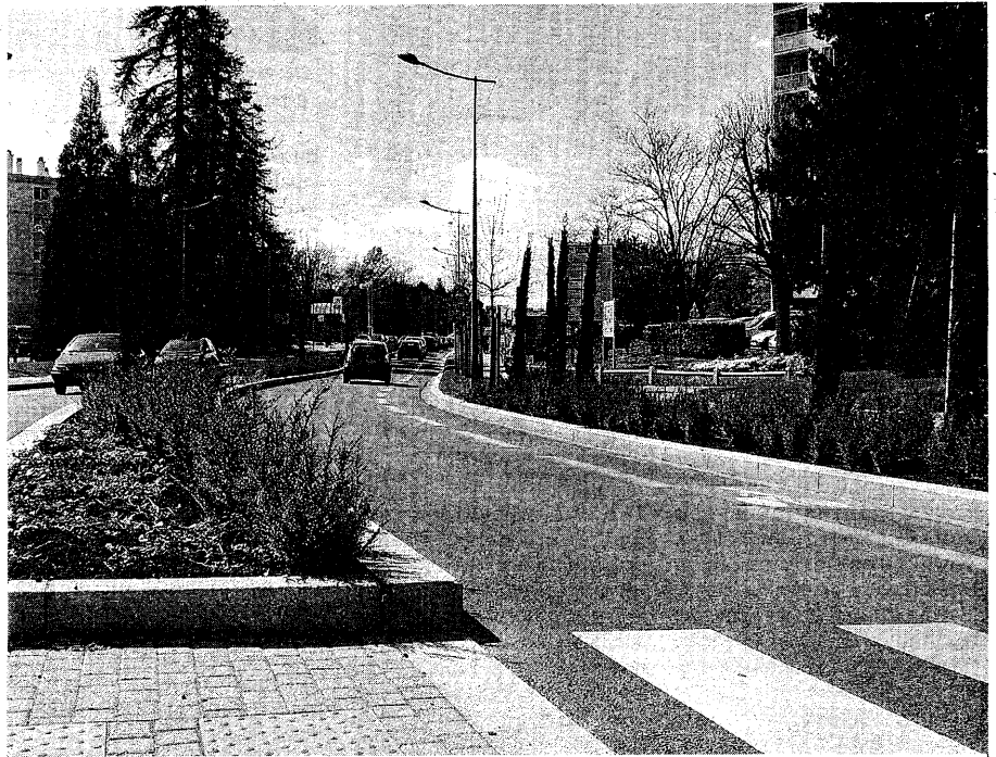
La restructuration de l'avenue de l'Yser est l'un des gros chantiers de la mandature
